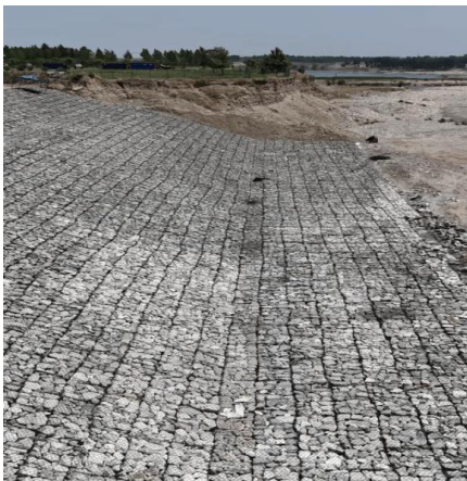
图1 该河道的高标准施工案例现场实拍图
