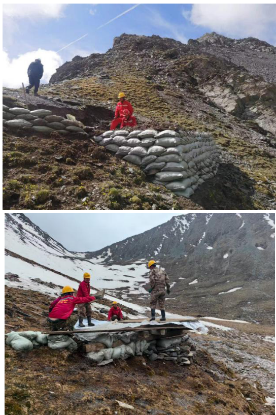
图1 机台修建现场图
