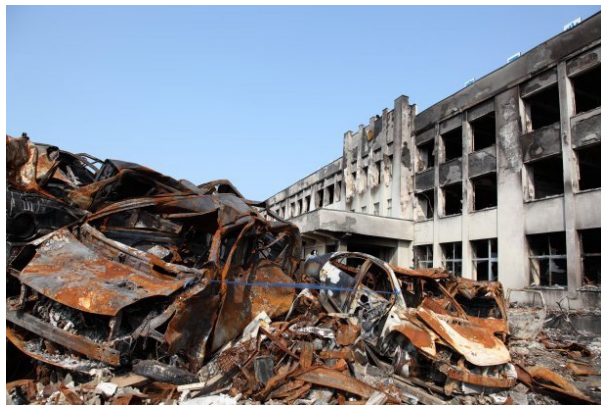
图 1 汶川地震后的房屋场景
